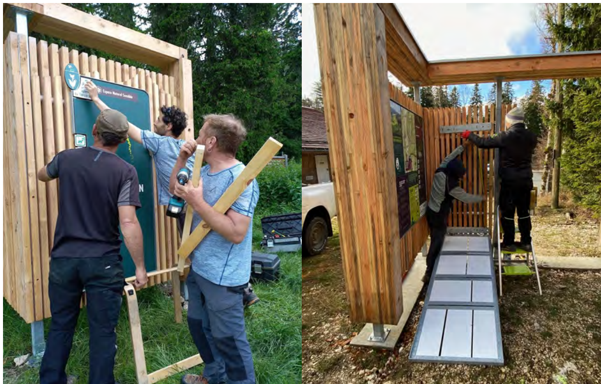
Pose de panneaux d'information sur la structure
