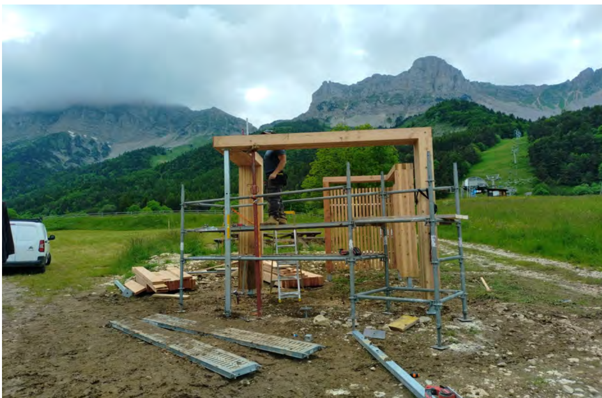
Chantier d'installation du mobilier à Gresse-en-Vercors
