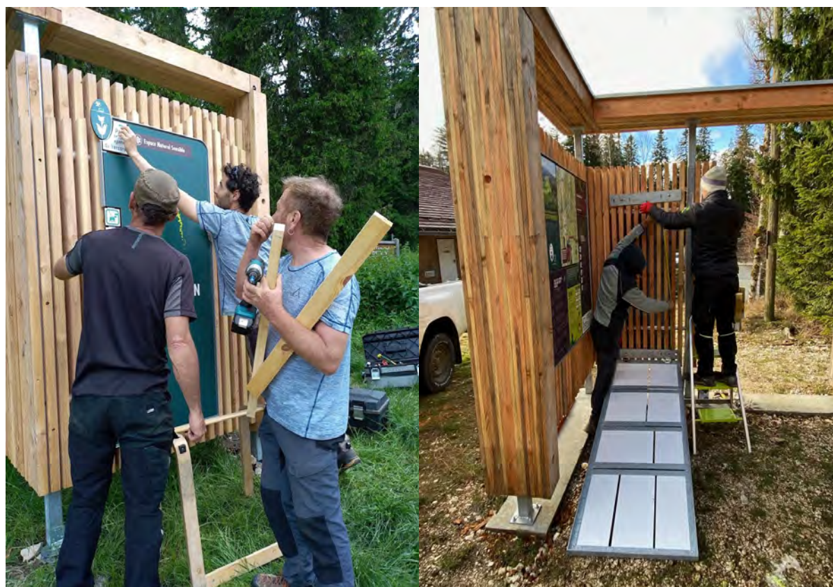
Pose de panneaux d'information sur la structure
