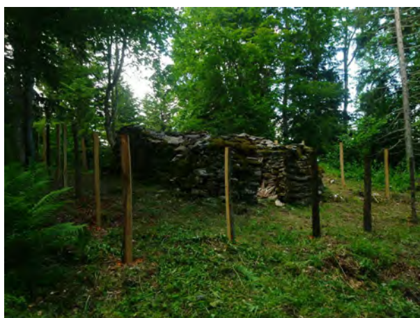
L'ancienne bergerie sur la commune d'Autrans-Méaudre-en-Vercors
